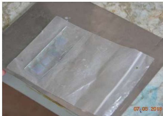
Figura 29. Colocación de plástico resistente al calor.
